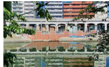
階段護岸（雁木）の痕跡（現在：大岡川桜橋）
