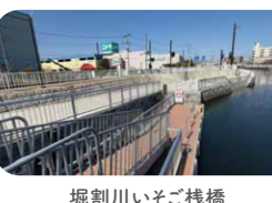
堀割川いそご棧橋
